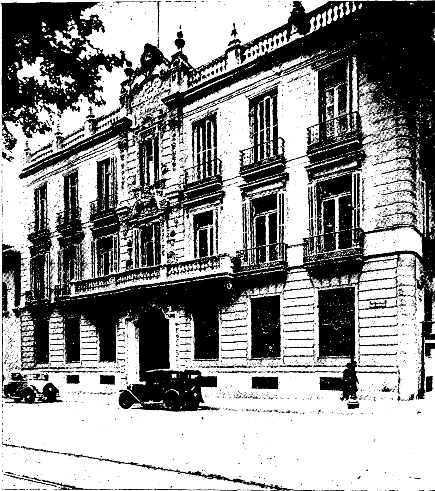
Edificio social, propiedad del Banco
